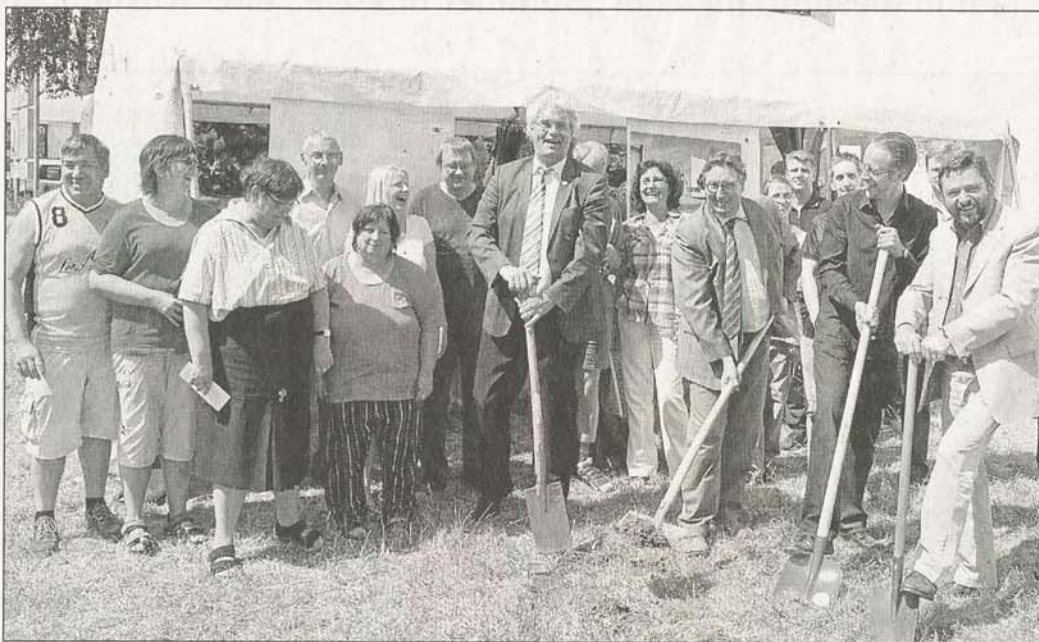
■ Im Beisein der zukünftige Mieter und deren Angehörigen vollzogen Bürgermeister Albert Bergmann (mit Spaten, v.l.), Lebenshilfe-Geschäftsführer Rolf Emmerich sowie die Investoren Jörg Wollenweber und Joachim Stiller den ersten Spatenstich. FOTO: TORSTEN BEULEN
